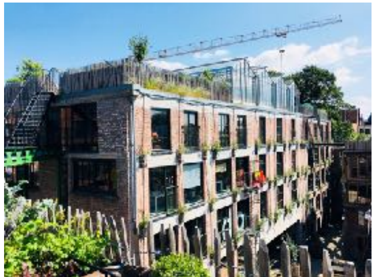
Dachgärten im Groen Kwartier
